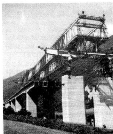
Pont poussé (revue Gico Costruzioni)
